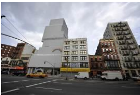
34 pav. Šiuolaikinio meno muziejus, Niujorkas, 2007 m. (arch. SANAA Architects)
