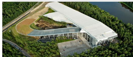
Slidinėjimo trasų kompleksas „Snow Arena“
